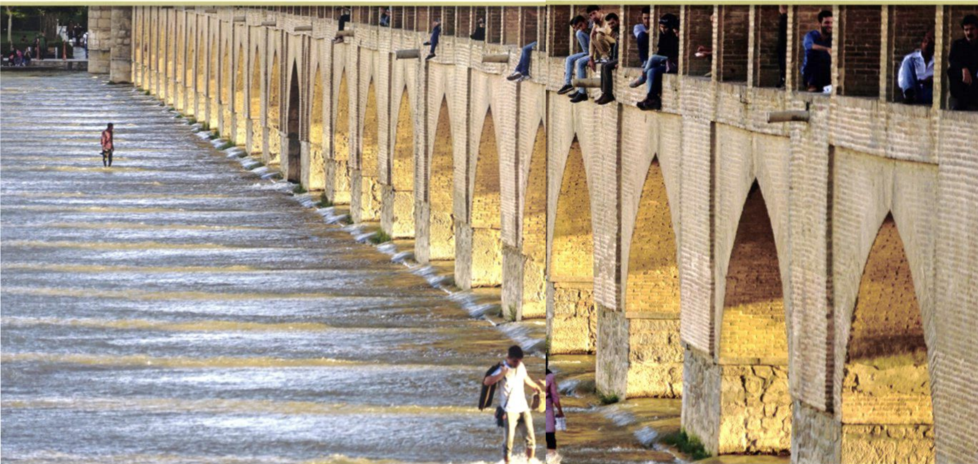
„Si-o-Seh-Pol“, die „Brücke der 33 Bögen“, ist nur eine von insgesamt vier historischen Brücken im Stadtgebiet von Isfahan über den Zayandehrud. Sie wurde vor geraumer Zeit aus Gründen des Denkmalschutzes für den Autoverkehr gesperrt und ist seither ein umso beliebter Treffpunkt für Flaneure.
